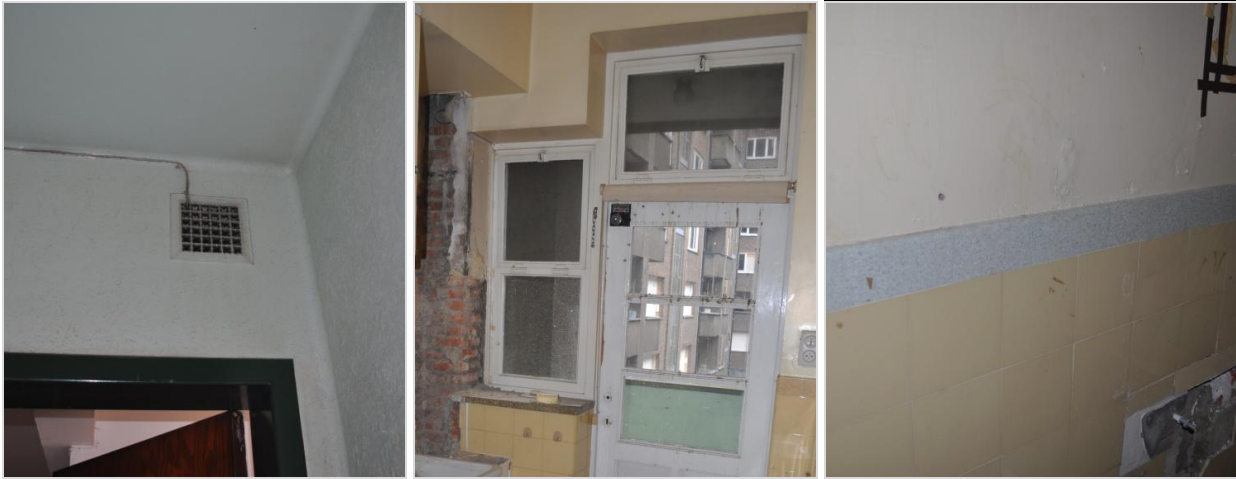
Figuur 39: Antwerpen, Fierensblokken, verluchttingsrooster aan de ingang van een appartement, tuimelramen, betegeling in de keuken en badkamer, grote blok, eigen fotomateriaal, toestand van maart 2016.
