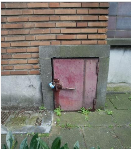
Figuur 123: Fierensblokken, blauwe afsluitklep voor een vuilshuif op het balkon; afsluiting van een vuilnisverzamelpunt, eigen fotomateriaal, toestand van november 2015.
