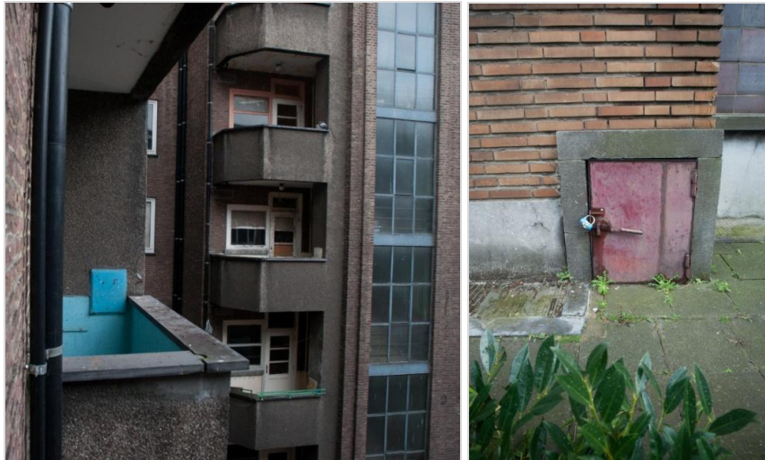
Figuur 24: Antwerpen, Fierensblokken, vuilniscirculatiesysteem, eigen fotomateriaal, toestand van november 2015.
