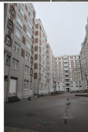
Figuur 86: Twee Netenstraat, voorgevel, inrit en binnenplaats, eigen fotomateriaal, toestand november 2015.
