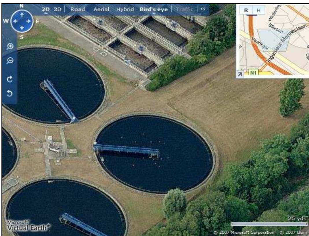
Afbeelding 27.1: “Detail-luchtfoto’s (“bird’s eye”) van een zone met sportveld en volkstuinen (boven) en van een waterzuiveringsstation (onder) te Merkssem” (Microsoft® Visual Earth™).
