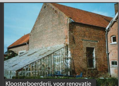
Kloosterboerderij, voor renovatie
