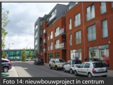
Foto 14: nieuwbouwproject in centrum
