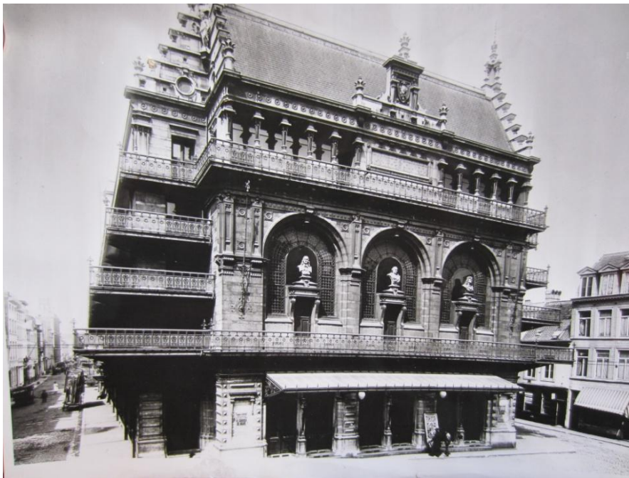
1 De schouwburgconstructie van architect Jan Baes was in 1887 erg vooruitstrevend. Via de vier brede balkons aan de zijgevels konden de toeschouwers het gebouw snel verlaten in geval van nood. Vooraan pronkten drie borstbeelden van Willem Ogier, Joost van den Vondel en Pieter Langendijk.
